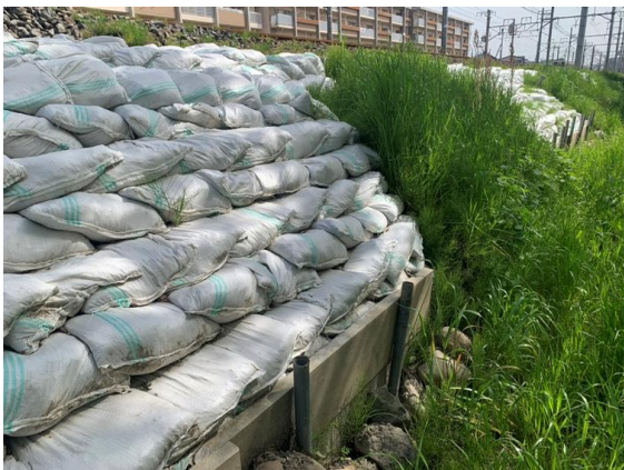
工事前の様子
