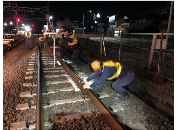
夜間作業の様子
