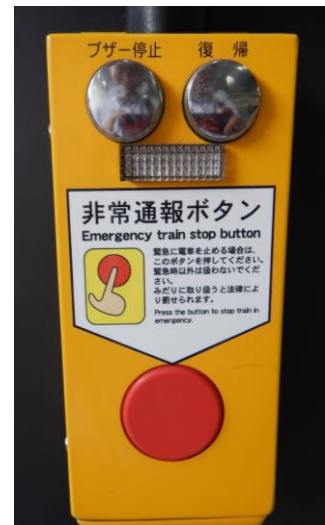
非常通報ボタン
