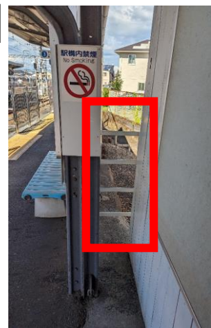
安全柵の設置
