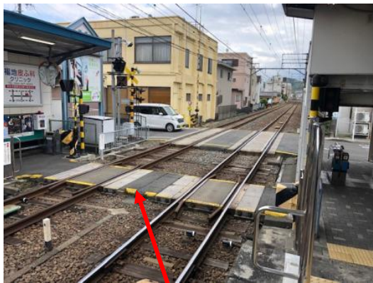
廃止された構内踏切
