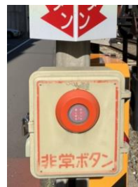
踏切「非常通報ボタン」
